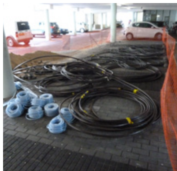
Leidingwerk voor de sanering in Zeist
