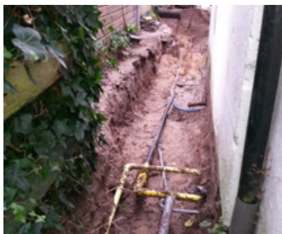
Ontgraving riooltrace Doorn
