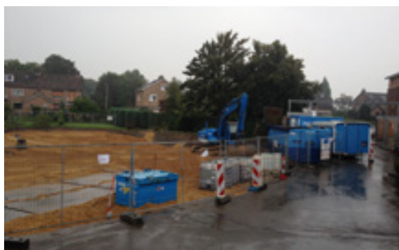
Aanvulling na ontgraving bronzone Elst
