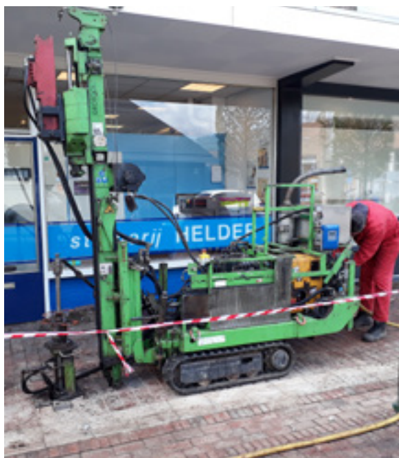
Uitvoering directe injectie hulpstoffen
