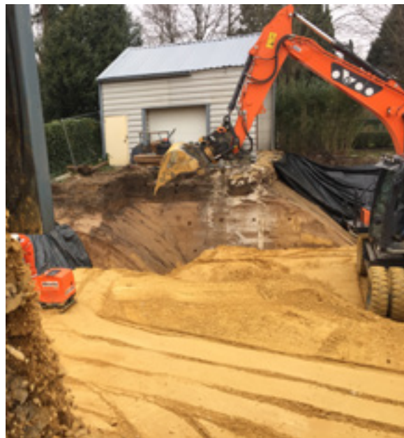
Aanvulling ontgravingsput met schone grond
