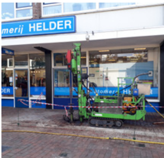
Uitvoering directe injectie hulpstoffen
