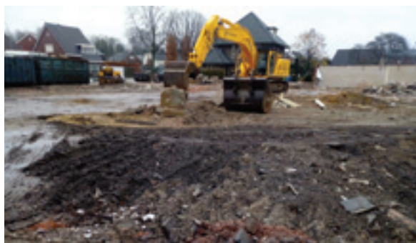
Sloopwerkzaamheden Willenstraat Aalten
