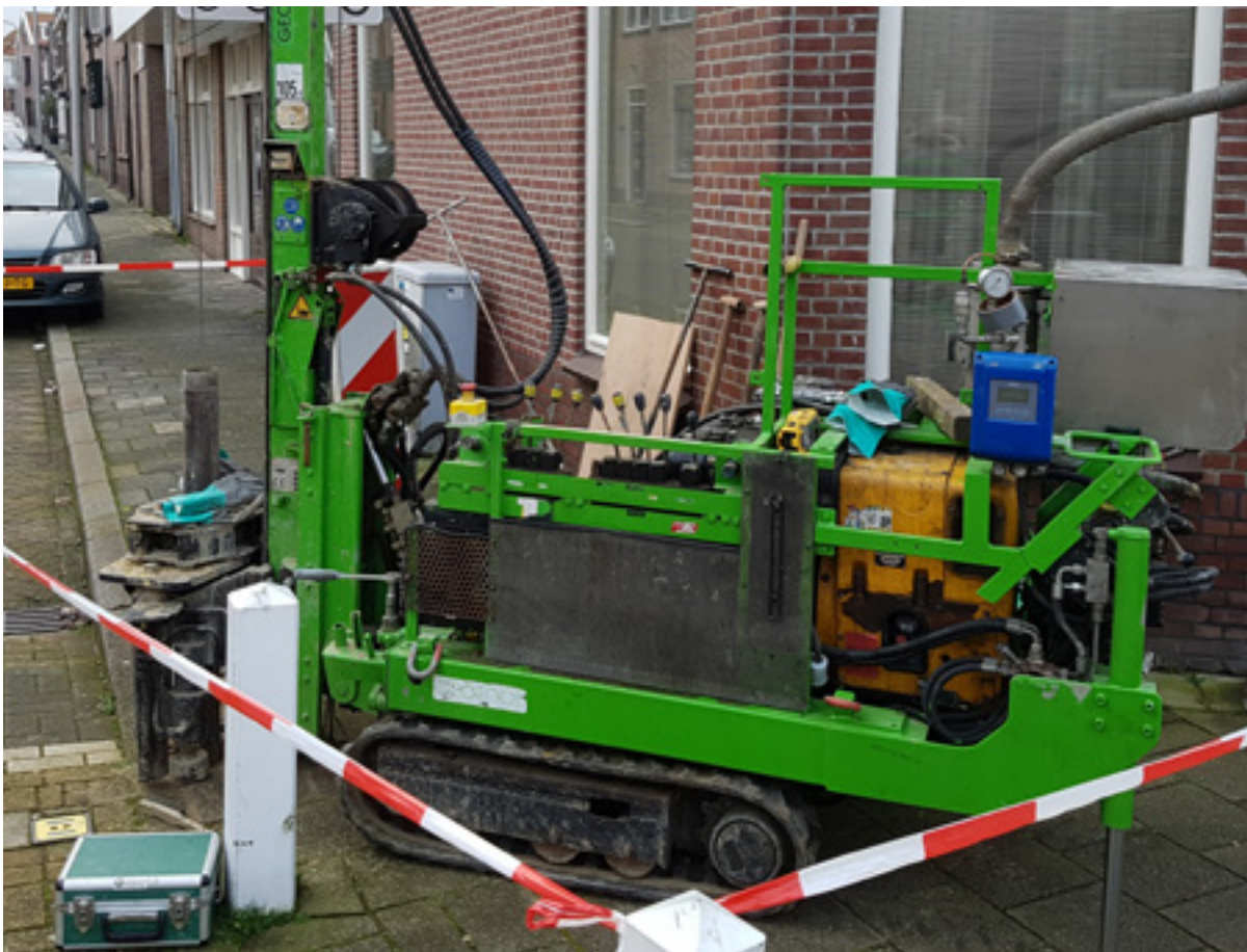
Plaatsing doseerfilters bronzone Katwijk
