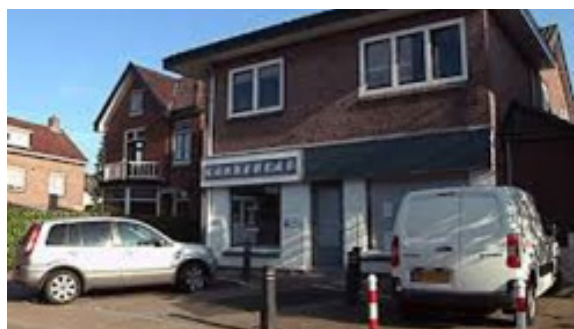
Plaatsing van injectiefilters
