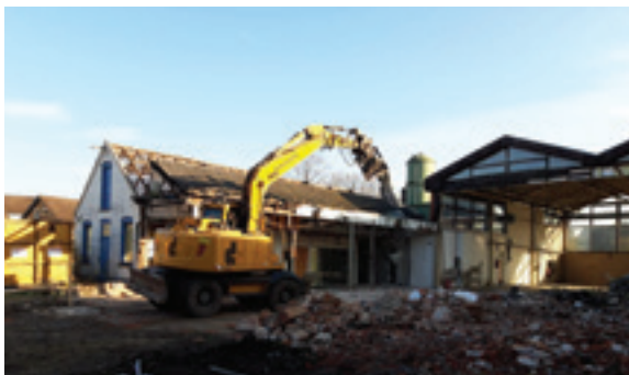
Sloopwerkzaamheden Willemstraat Aalten
