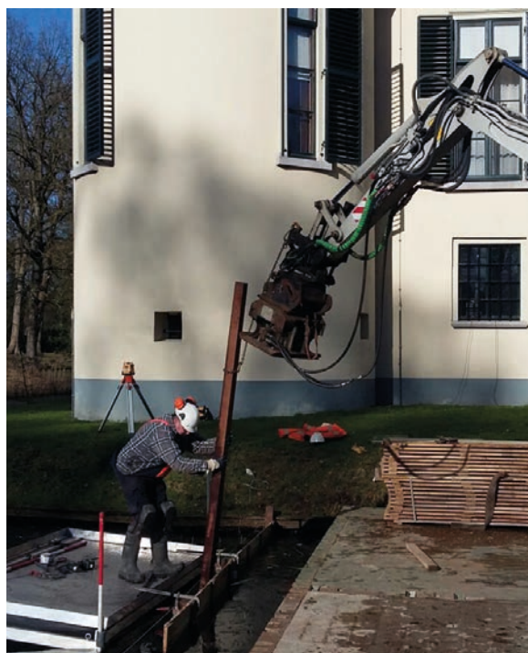
Aanleg natuurlijke zuivering slotgracht Huis Doorn
