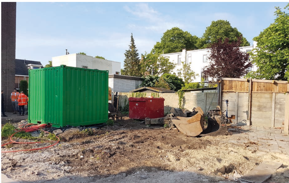
Breda - Plaatsing in-situ saneringssysteem grondwater
