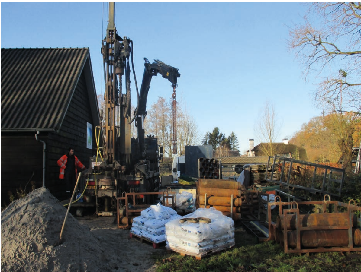
Plaatsing diepe bron bij kwekerij
