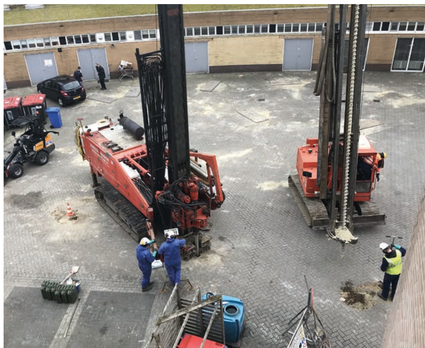
Emmen - Plaatsing infiltratiebronnen
