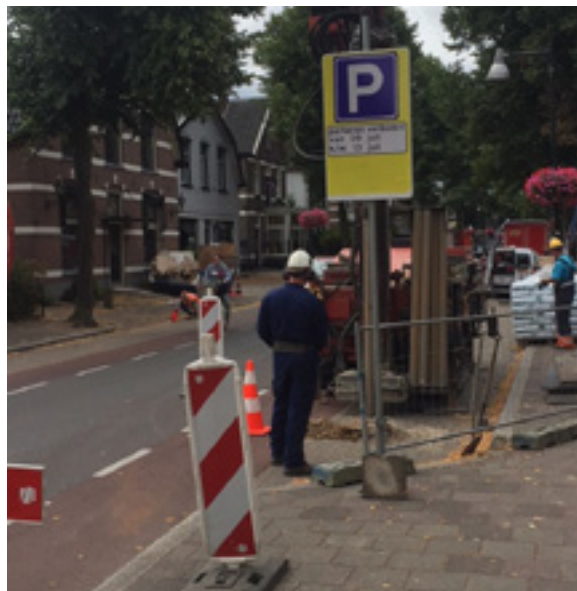
Werkzaamheden openbare ruimte
