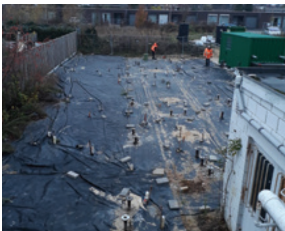
Ontmanteling kabels en leidingen actieve fase Hoensbroek
