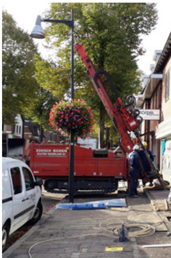
Plaatsen doseerfilters onder pand
