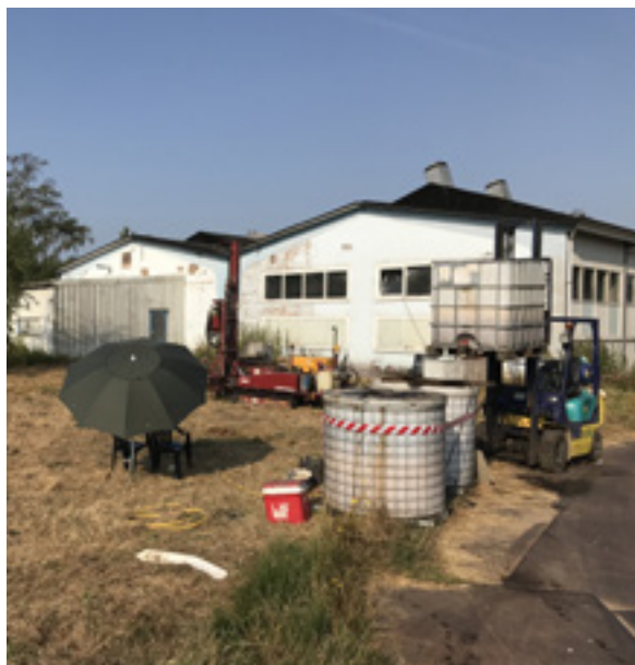
Uitvoering injecties Dammerweg Nederhorst den Berg
